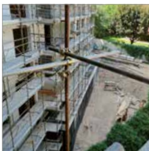
Ponteggio misto tubo giunto e portale
