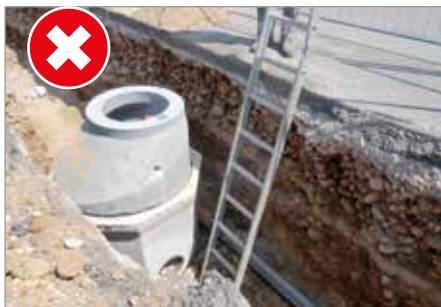
Assenza di protezioni
