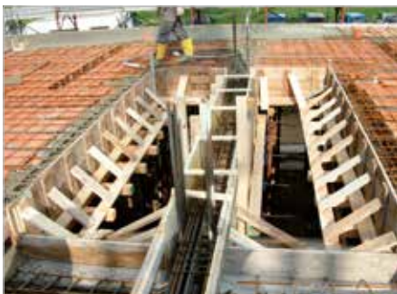
Aperture con rischio di caduta dall'alto
