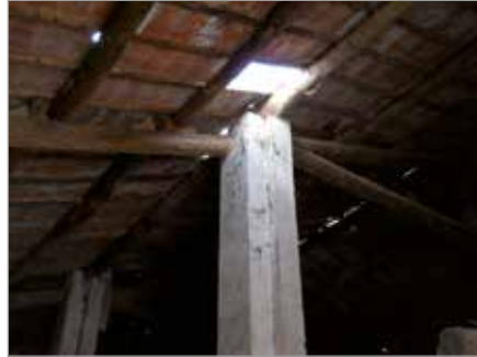
Sfondamento copertura non portante in fibrocemento ecologico
