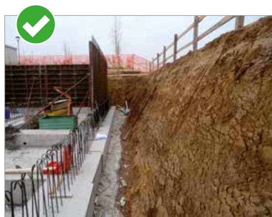
Parete di scavo con corretta inclinazione
