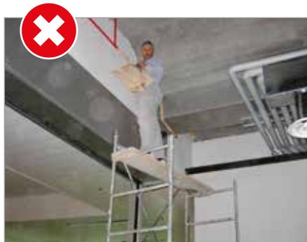
Piano di calpestio incompleto e assenza parapetti
