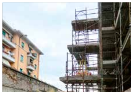
Torre di carico
