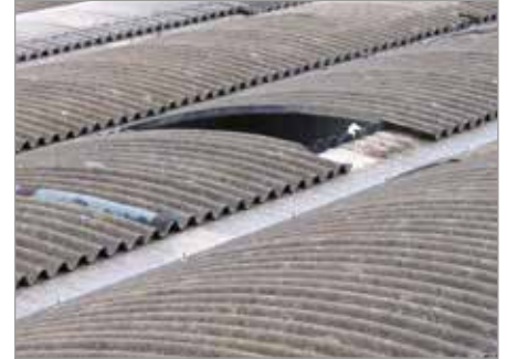
Sfondamento copertura non portante in laterizio
